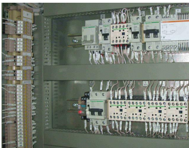
Рисунок 8.1 – Аппаратура вспомогательных цепей ЩСН
