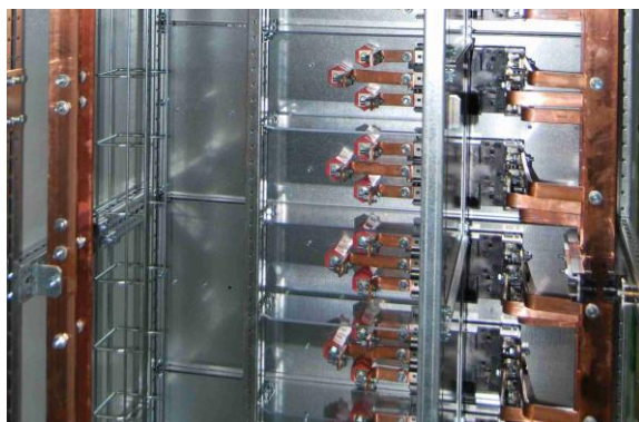
Рисунок 7.11 – Отводы из медных шин для подключения фидеров
