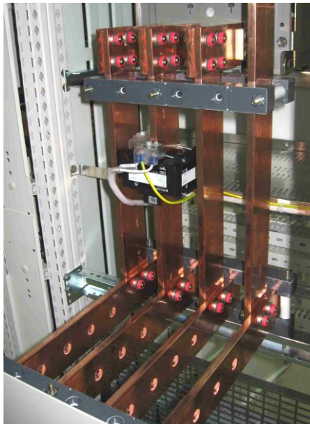
Рисунок 7.9 – Узел подключения кабелем от ТСН
